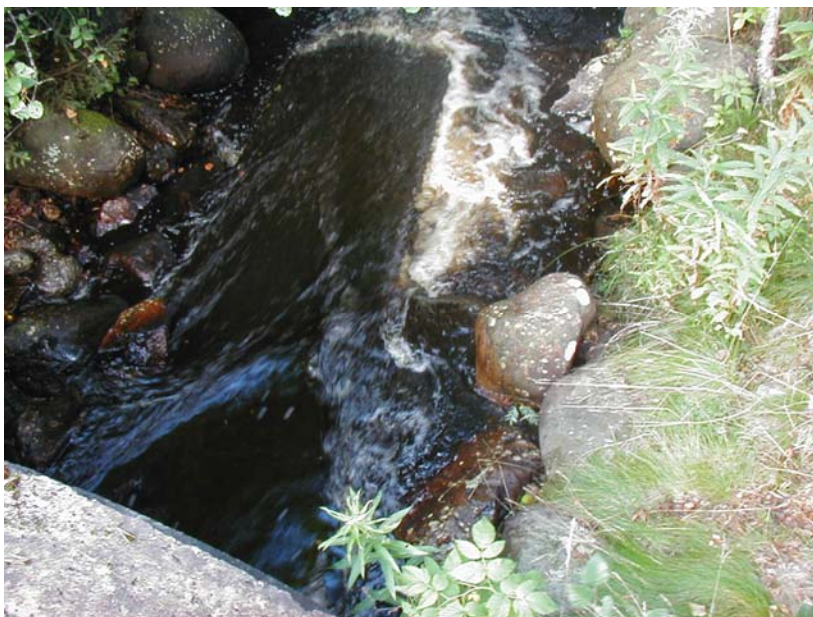
Figur 2. Utflödet från vägtrumman sett uppifrån.
