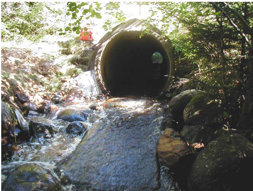
Figur 6. Efter åtgärd, jämför med fig.1. Styrplåten ses i ovankant på betongplattan, den styr ut vattnet till den breddade bäckfåran där stenar lagts ut. Markduken har klätts in med sten och sand. Ovanpå har också de grästuvor som tagits bort för åtgärden åter lagts på. Detta borde skynda på stabiliseringen av strandkanten. Åtgärder har även skett inne i trumman. I trummans övre del var vattenhastigheten hög och vattendjupen litet, i trummringarnas skarvar knackades små galvade plåtar ner, dessa skapade effektivt småhöljor ( trappsteg) som underlättar fiskens passagemöjligheter.
