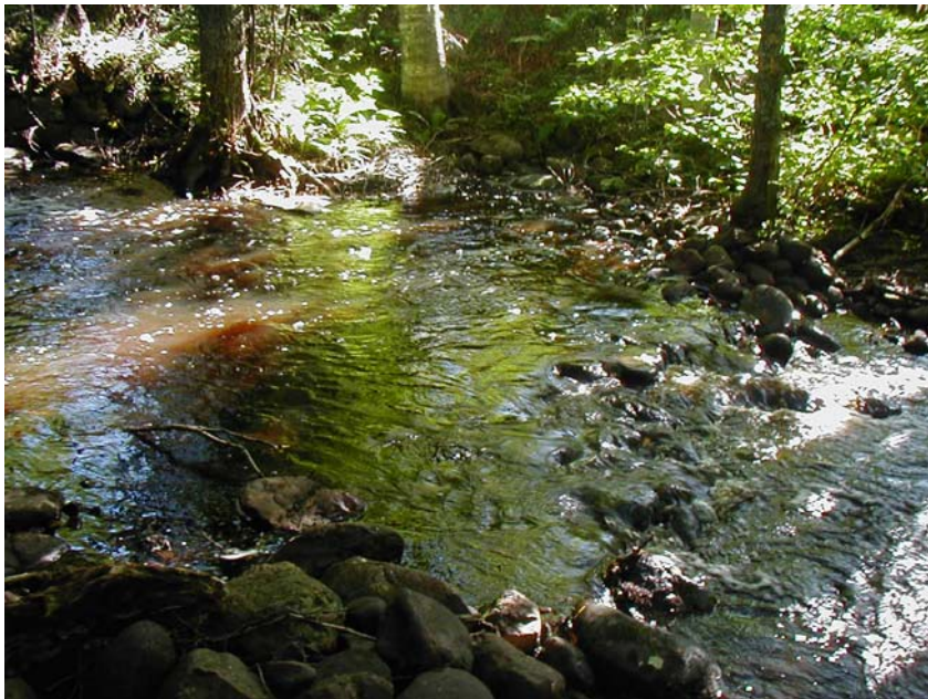
Figur 8. Höljan bakom förstärktes genom att sten och block lades ut på strömnacken nedanför trumman. På detta sätt kunde vattennivån nedan trumman höjas och fallhöjden vid utloppet minimeras till ca 5-10 cm. Bilden visar efter åtgärd.
