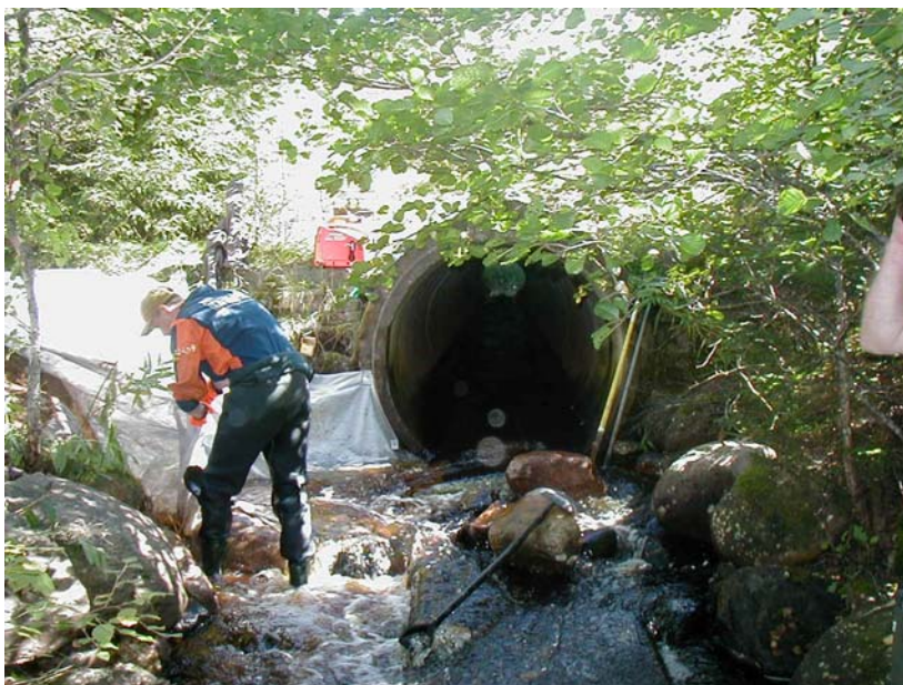
Figur 4. Markduken fästs i betongplattan och dras sedan upp på strandkanten, detta för att stabilisera strandkanten och säkra mot erosion.
