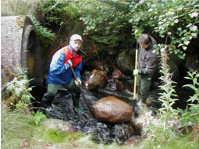
Figur 3. Den högra strandkanten breddades, block och stenmaterial togs bort.
