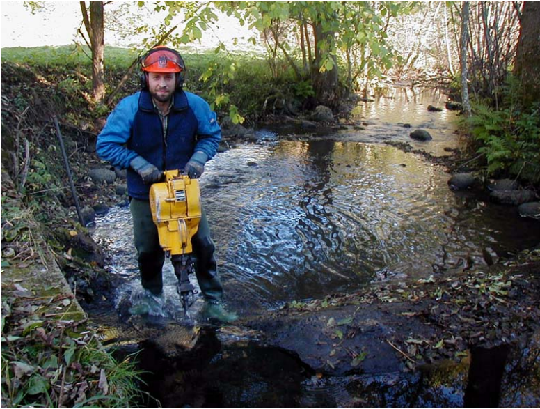
En skåra knackades ur i cementsockeln, ca 35 cm bred och 30 cm djup.
