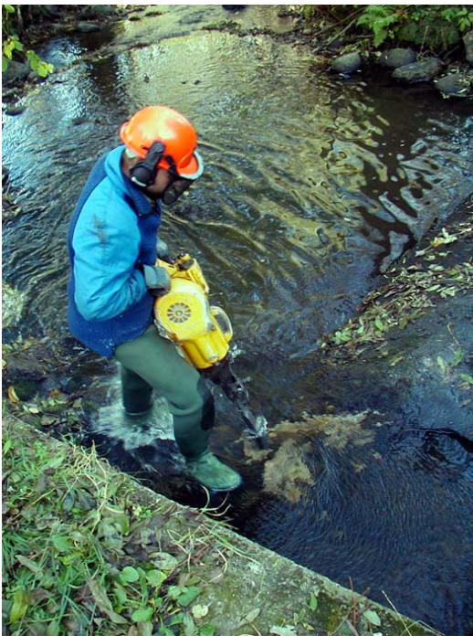
Betongen visade sig betydligt hårdare än beräknat.
