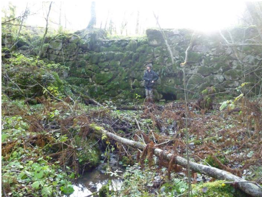
Bild 3 Blockdammen ca 160 m uppströms järnvägen. Den raserade delen av dammen ligger till vänster utanför bilden.
