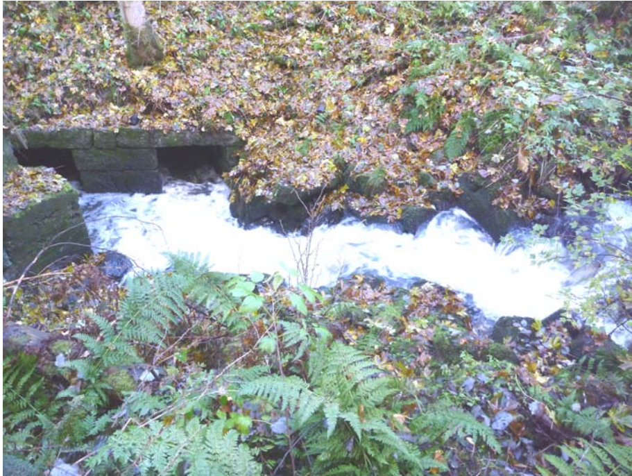
Bild 2 Fallet ovan järnvägs-kulverten, rester av kraftverket skymtar till vänster.
