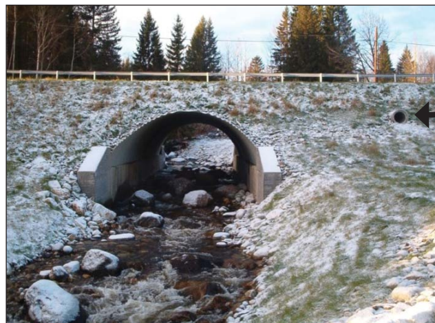
Bild 4. Exempel på torrtrumma (markerad med svart pil). Foto: Oskar Norrgrann
