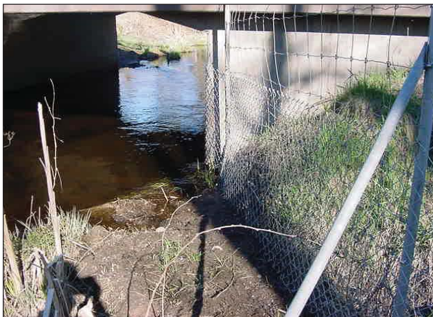
Bild 7. Finmaskigt stängsel för utter. Foto: Jakob Bergengren.
