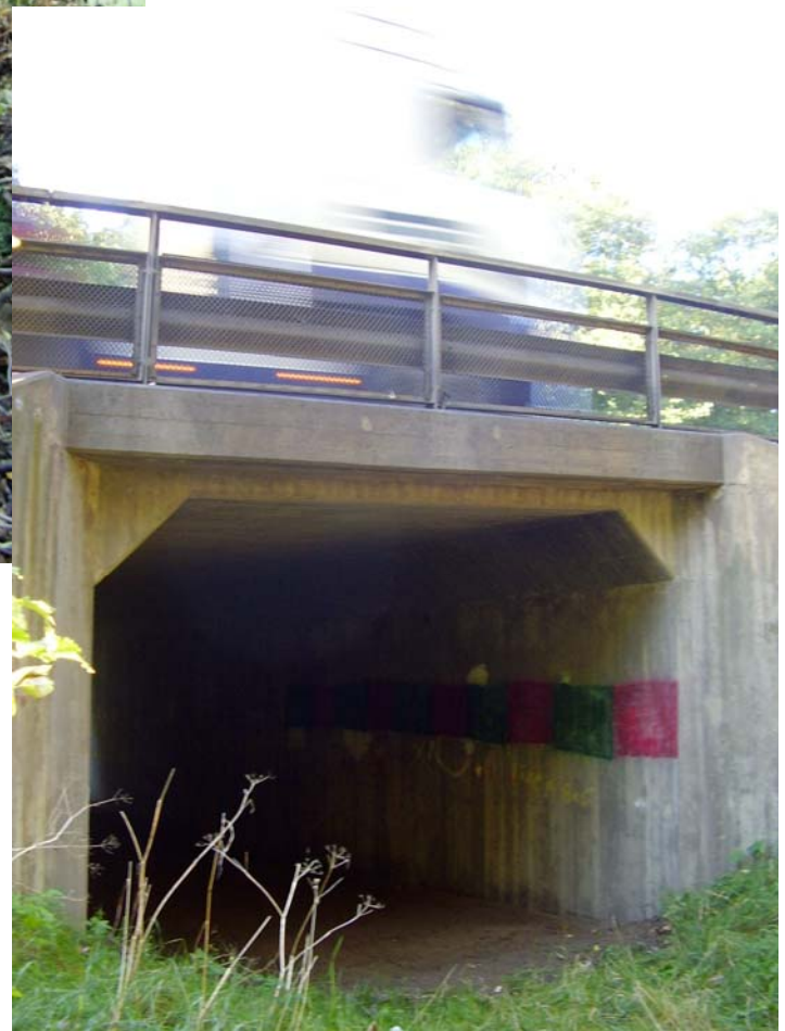
Porten i Göteborgsbacken under riksväg 40
