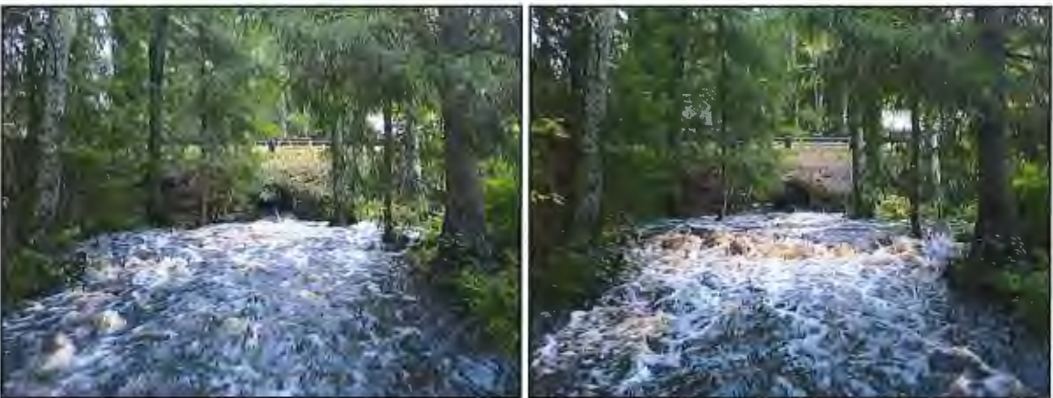
Figur 7. Trösklen nedan bron för grusvägen i Åsabäcken före respektive efter åtgärd (höjning av vattennivån för att underlätta fiskpassage) den 27:e september 2012 (foto: Peter Lindvall, Jönköpings Fiskeribiologi AB).
