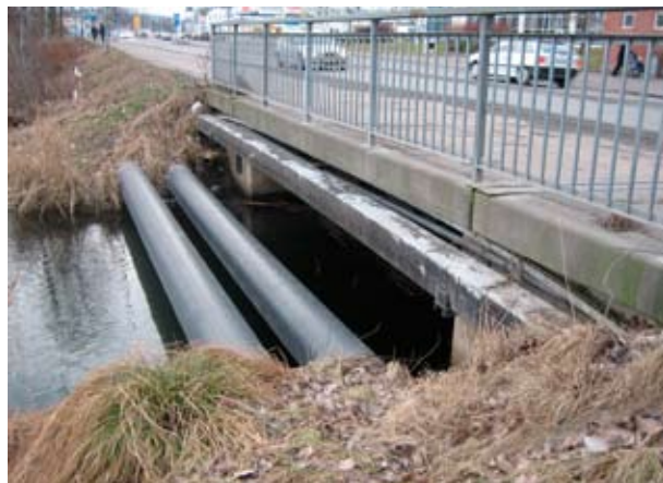
Befintlig bro över Rocksjön som föreslås ersättas av ny konstruktion som erbjuder vattenpassage och gc-underfart.
