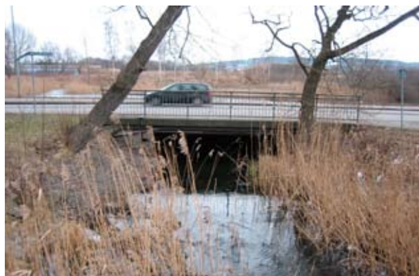
Befintlig bro över Rocksjön sedd från Munksjösidan.
