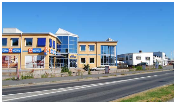
Bild 1.4 Byggnad nr. 711 och 710
