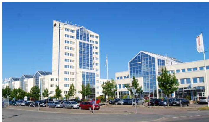
Bild 1.5 Byggnad nr. 701 och 702
