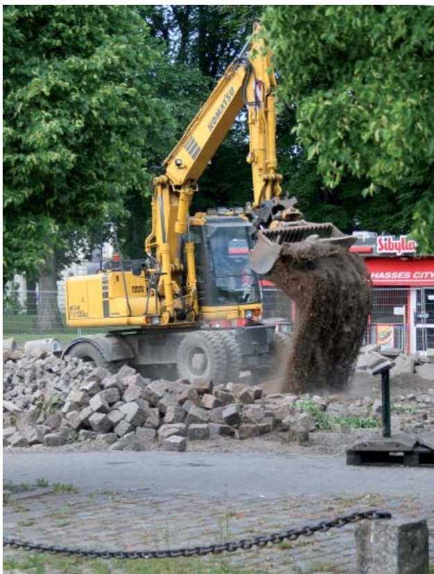
Ombyggnad av Hamnplan 2007
