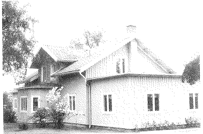
Kv Vargön 3, mangårdsbyggnad
