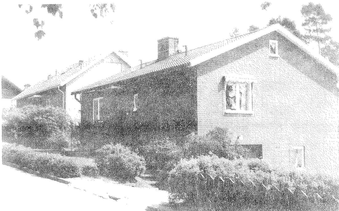
Kv Örserum 4 och 5
