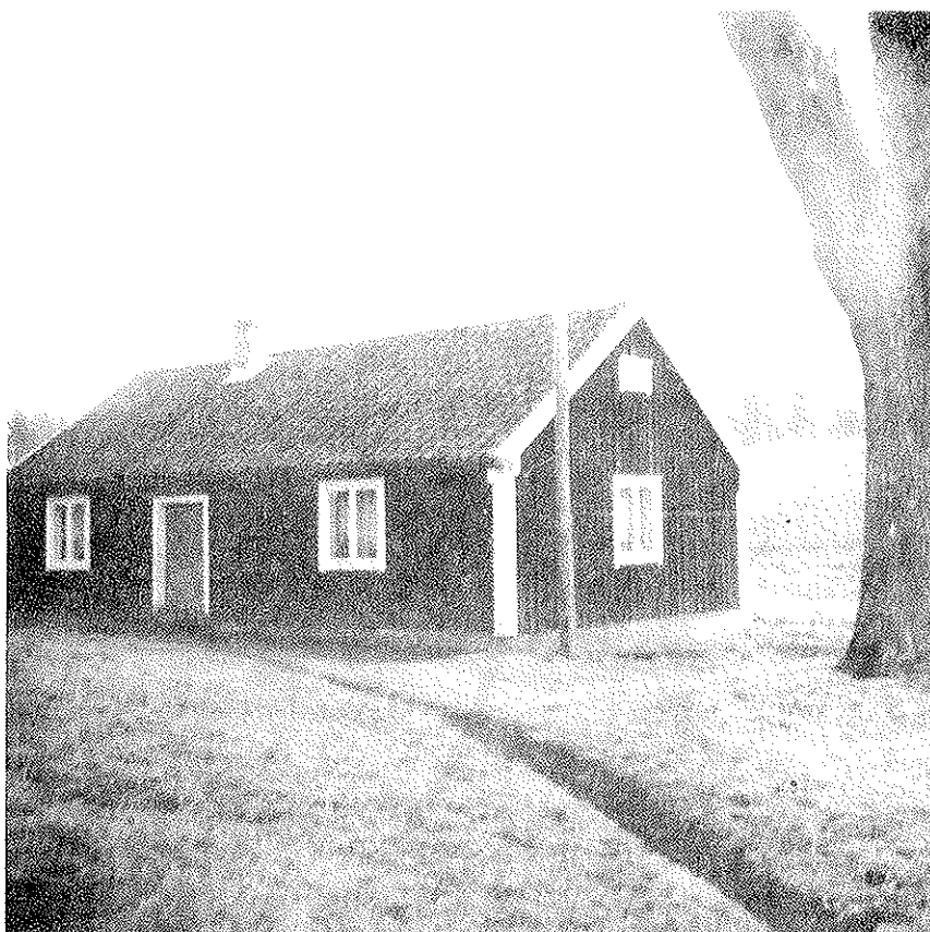
Statarbyggnad (numera riven) på Råslätts gård.
