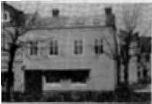
Kv Bägaren 3 (forts) Kanalgatan 5
