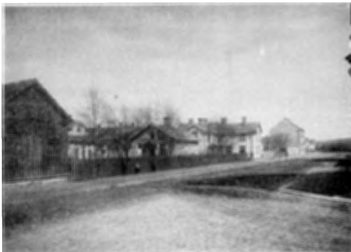
Kålgårdsgatan från Snickaregatan 1908. Den mindre byggnaden i bildens mitt användes som tvätt- och omklädningsrum av skorstensfejare Landén.
