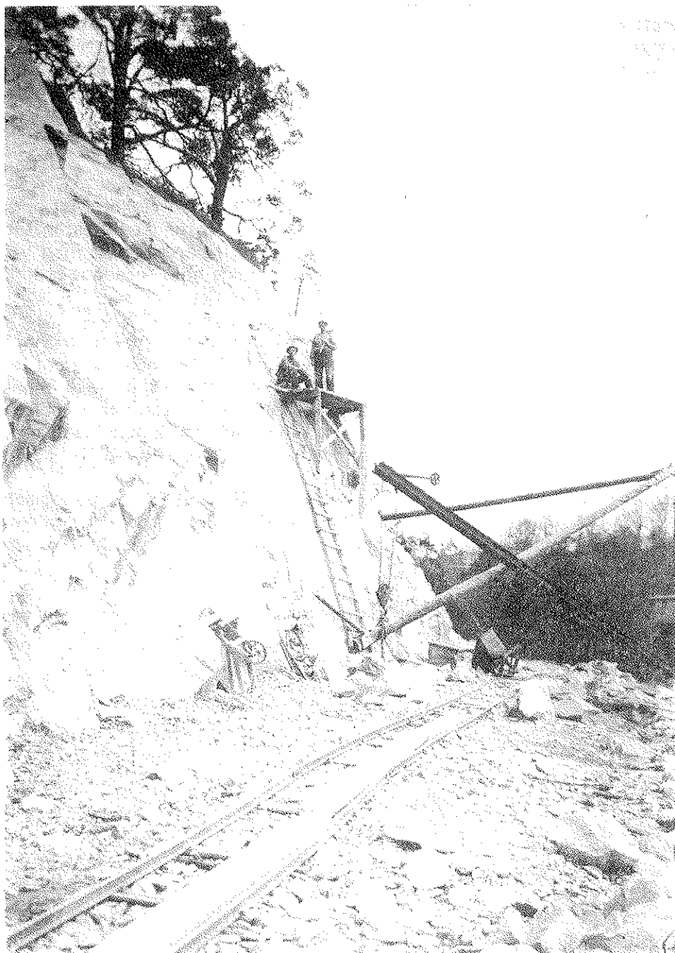
Ådalsvägen under byggnad på 1920-talet.
