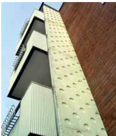
Punkthus i kv. Västerås - välbevarat vertikalt genomgående balkongparti i material som: formgjuten betong, järnsmide och korrugerad plåt.
