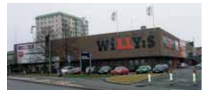
Österängens centrum vars läge markeras av ett högre punkthus.
