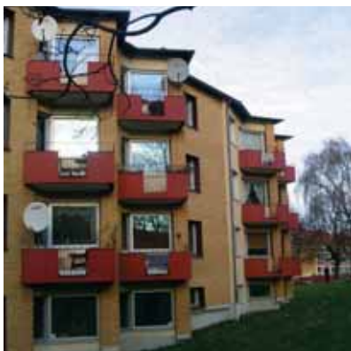
Bågformade lamellhus i kv Vidöstern 3, som visar hur byggnaderna placerats och utformats för att få tillgång till mycket solljus. Byggnaden har även ursprungliga balkong-räcken / fronter.
