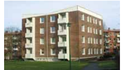
Punkthus i kv. Västerås.
