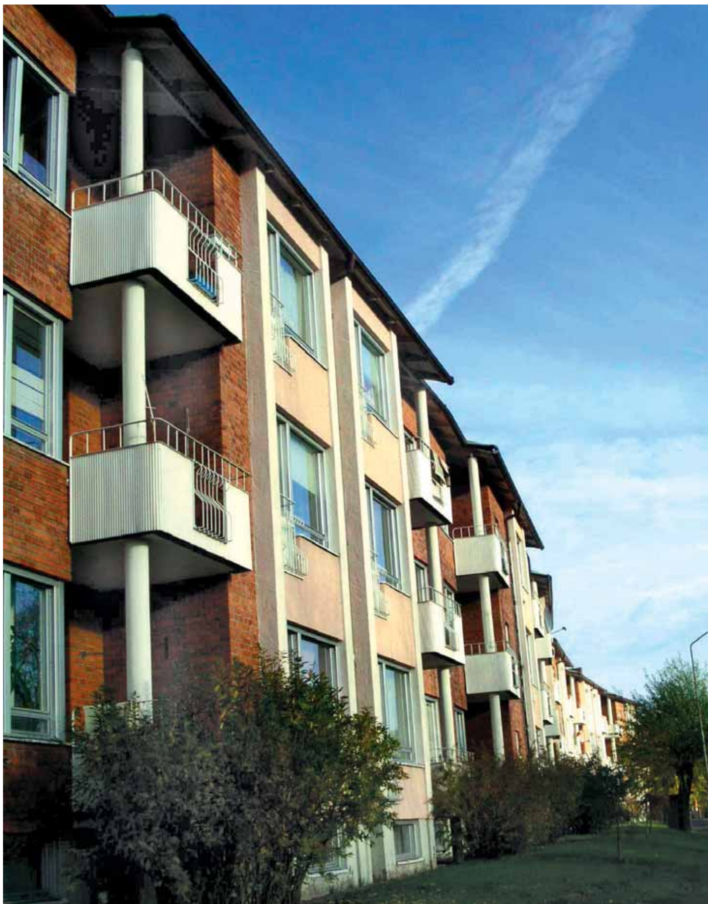
Kv. Vidöstern 6 - Burspråkspartier, franska balkonger och ursprungliga balkongpartier.
