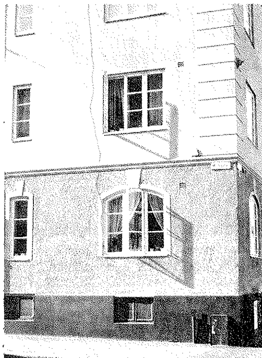
27. 20-tals fasad med spritputsad bottenvåning och slätputs i de övre våningarna, profilerat listverk och hörnkedjor.
