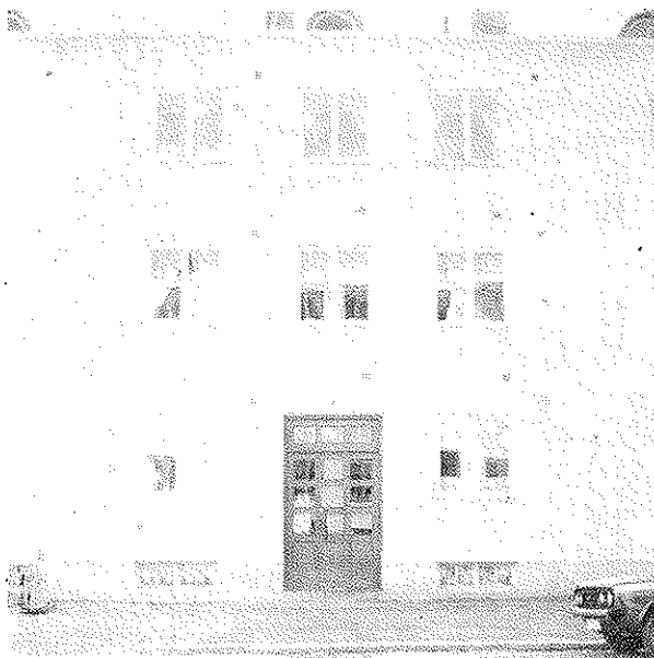
33. Fönster av funktionalistisk typ, utan spröjsning, grunt placerade i fasadlivet, 1936. Kniven 3.
