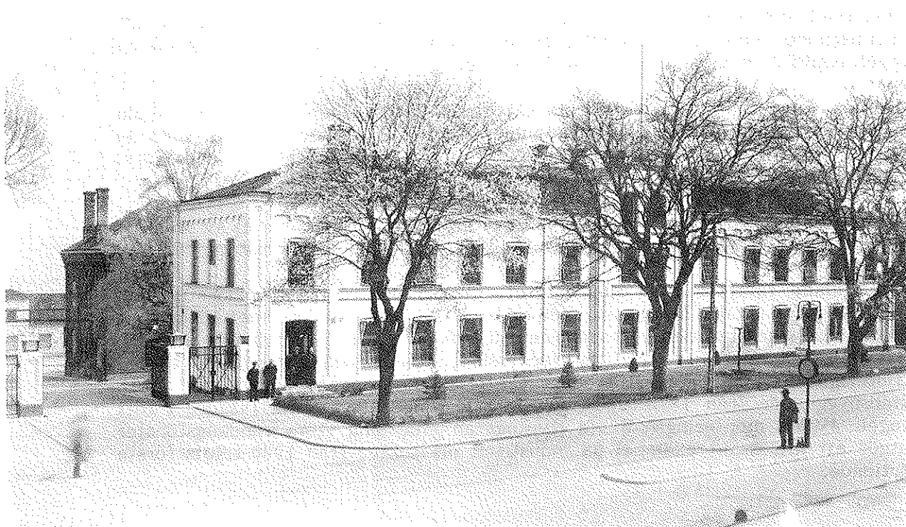
Jönköpings Tändsticksfabriks kontorsbyggnad efter anordnandet av den nya entrén 1934.
