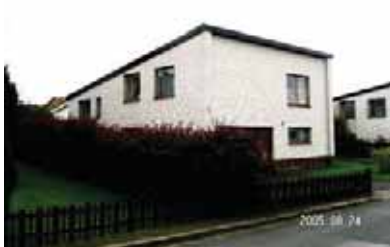
Gyllenstigen nr 5, Hörn mot nordöst.
