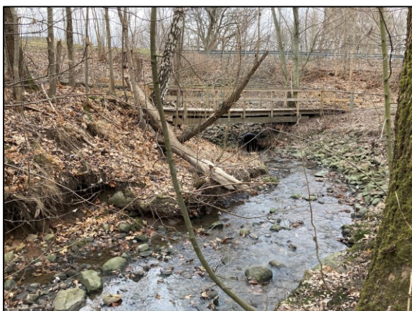
Bild 14. Skrämmabäcken mot kulvert under Mässvägen
