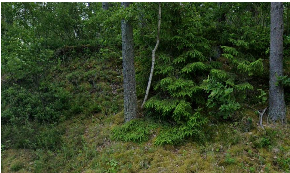
Figur 9. Bild på slänt i den nordvästra delen av detaljplanområdet, i bilden går det antyda att ras skett i slänten sedan tidigare. Skärmlapp från Google streetview 2024-12-03.
