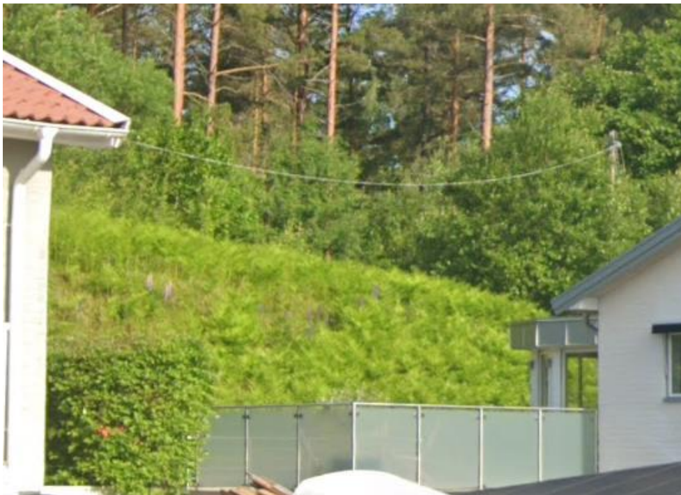
Figur 8. Bild på slänt i den östra delen av detaljplanområdet ner mot befintliga fastigheter. Skärmlapp från Google streetview 2024-12-03.
