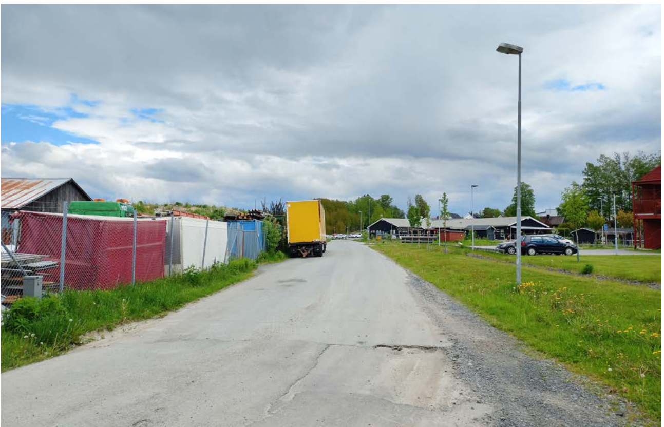
Bild 10. Vy mot öst med Verkstadsvägens nuvarande utformning och låga trafiksäkerhet och otydliga gaturum.
