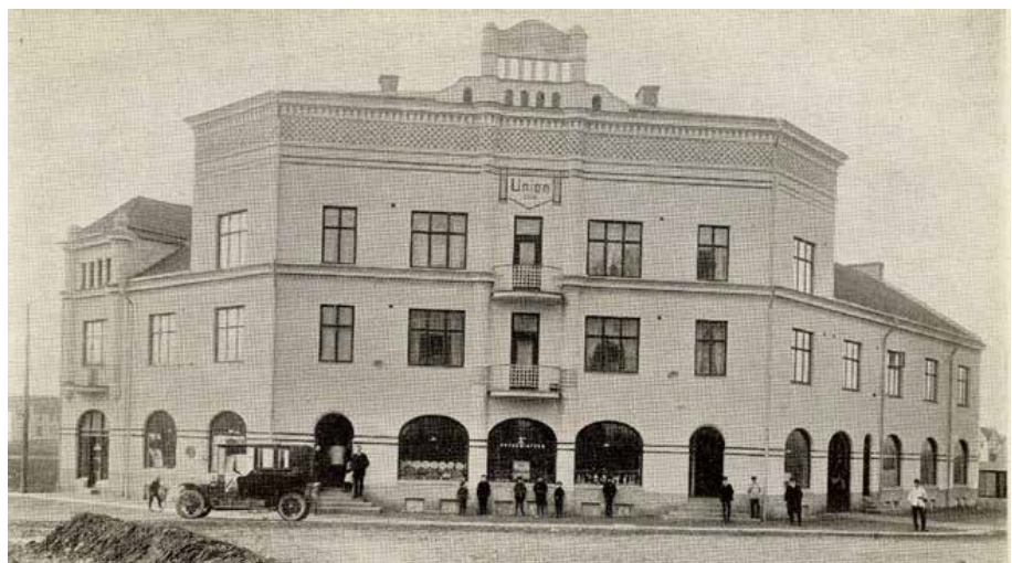
Figur 16. Det historiska fotot visar den ursprungliga byggnaden på platsen med gaveln ut mot nuvarande Erik Dahlbergs Plan.
