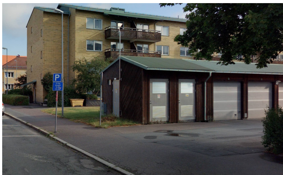
Figur 24. Fotot visar transformatorstationen på Union 17, till vänster.
