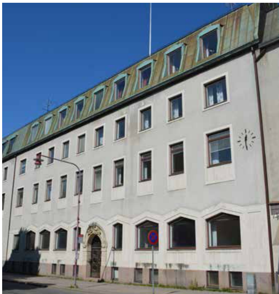
Figur 11. Fotot visar fasaden på den del som är det före detta stadshuset. I bilden ses bland annat fasaddekor i travertin runt fönster och huvudentrén med sandstensportalen.
