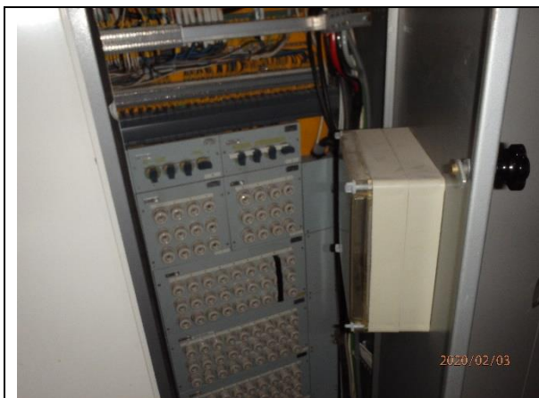
Elcentral med batterier
