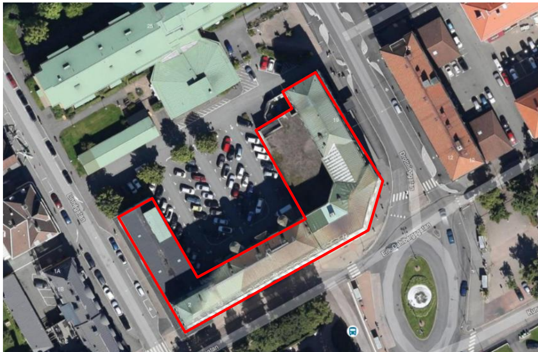
FIGUR 2 BYGGNAD FÖR MILJÖINVENTERING
