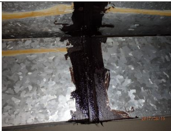
Prov 4 svart ventkitt, analys påvisar lågt halt PCB. Prov 5 och svart vent kitt, asbest
