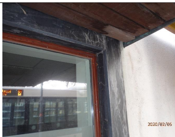
Prov 22 mjukfog runt fönster, ingen asbest i prov
