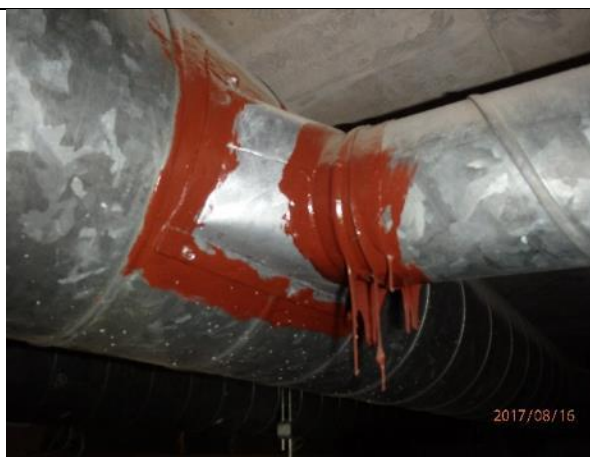
Prov 10 Rött ventilations kitt, asbest i prov
