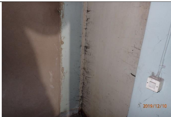
Ståldörr med asbestisolering .
