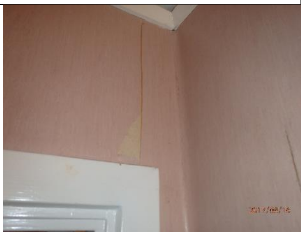
Prov 14 ljus väggmatta, asbest i prov
