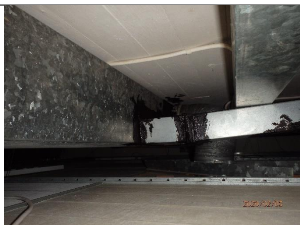
Ventilations kitt med asbest och PCB
