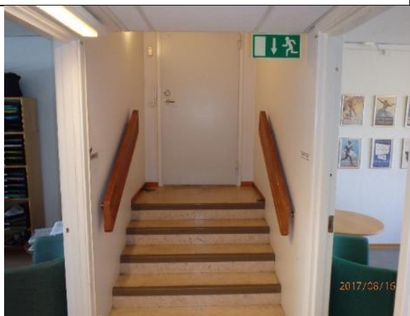
Ståldörr med isolering av asbest
