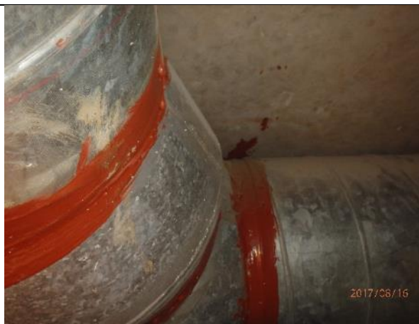
Prov 11 Rött ventkitt, asbest i prov
