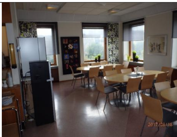
Matsal och isolerglasfönster Emmaboda 11-67 PCB i fönster.
