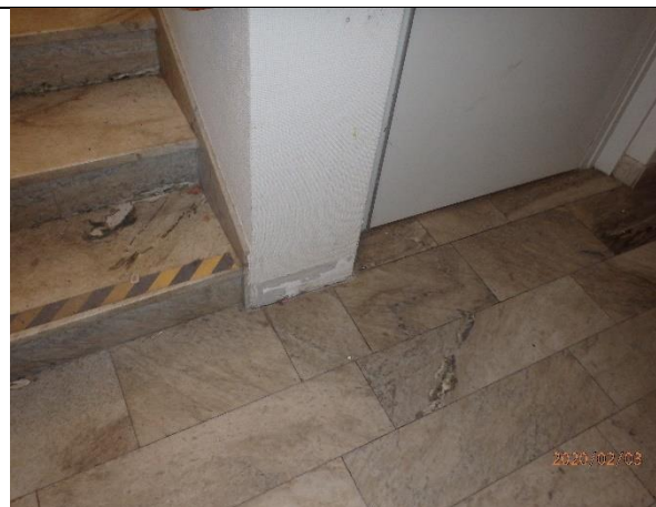
Prov 18 klinkerfix asbest i prov, marmorskivor i hella trapphuset
